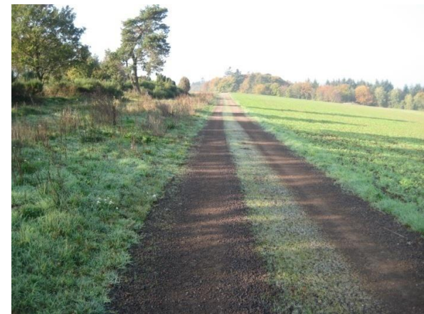
Fertige Wege mit verschiedenen ungebundenen Deckschichten
