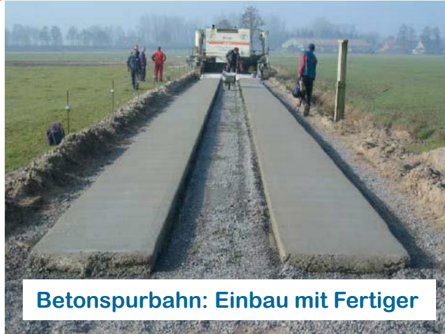
Spurbahnweg mit seidl. Rigole
