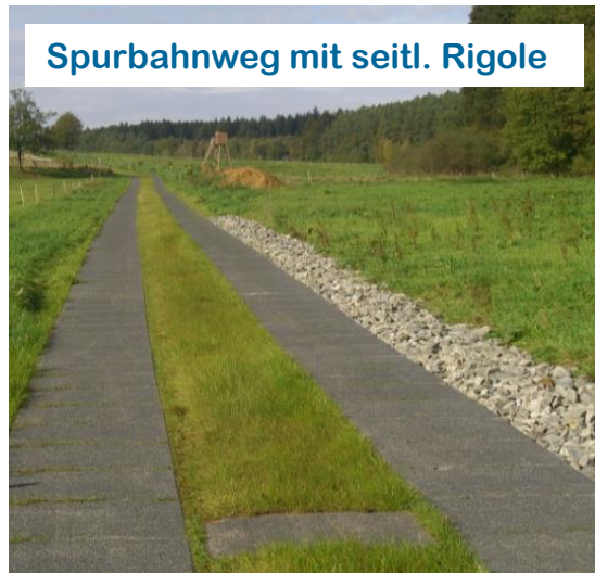
Betonspurbahn: Einbau mit Fertiger
