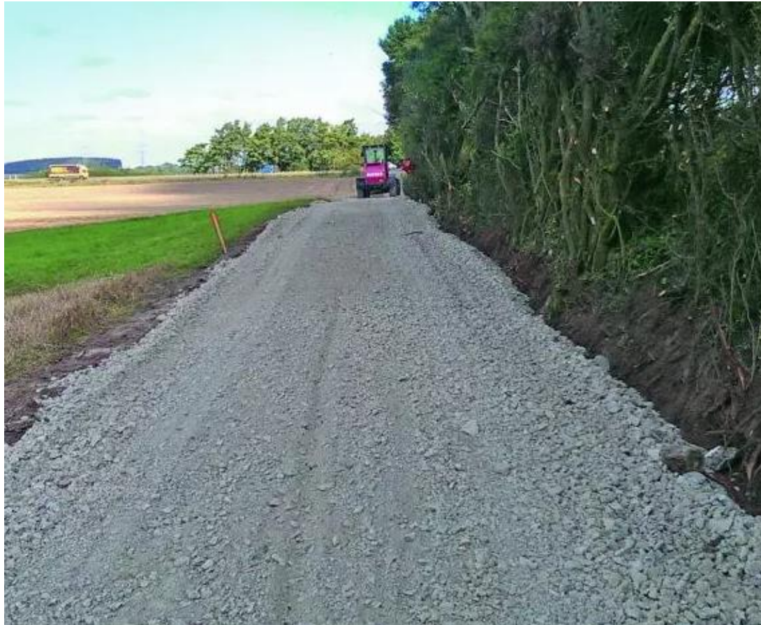
Einbau der Frostschutzschicht mittels Grader.
