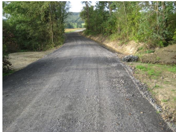
Fertige Wege mit verschiedenen ungebundenen Deckschichten
