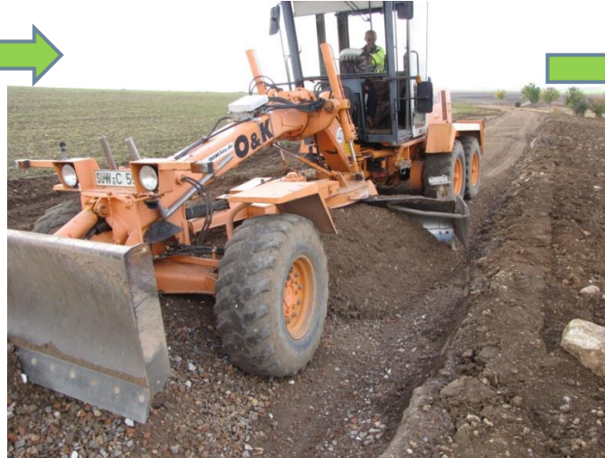
Ausgleichen der Tragschicht
