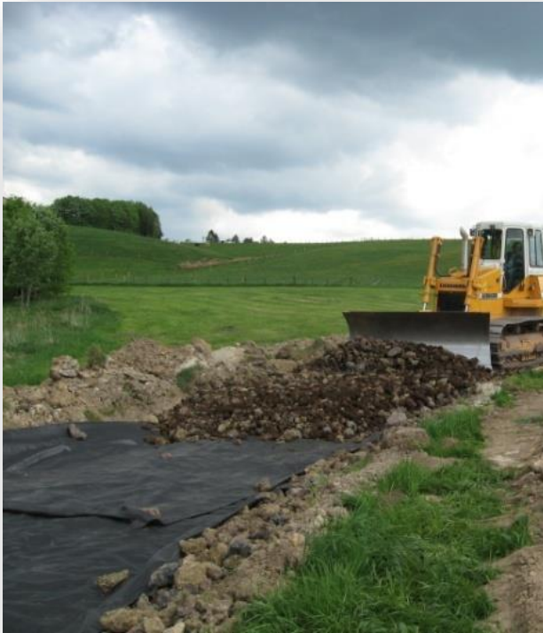
Preis Geotextil abhängig u.a. von der Stempeldurchdruckkraft
