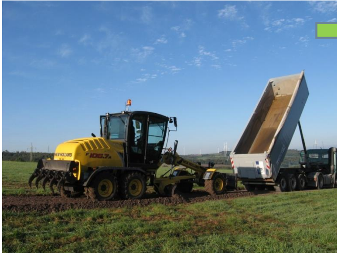
Schüttung der Tragschicht
