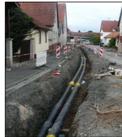
Verlegung eines genossenschaftlichen Nahwärmenetzes im Dorf
