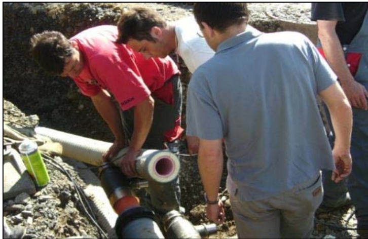
Verlegung eines genossenschaftlichen Nahwärmenetzes im Dorf
