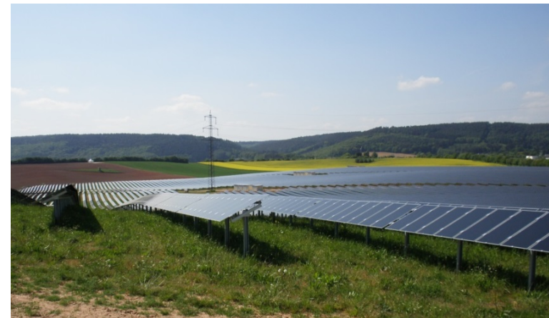
Solkraftwerk Föhren im Industriepark Region Trier (Leistung: 1 MW auf 25 ha)
