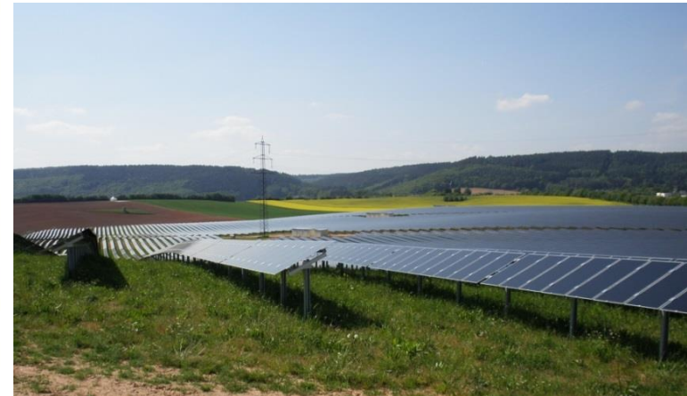
Solarkraftwerk Föhren im Industriepark Region Trier (Leistung: 1 MW auf 25 ha)
